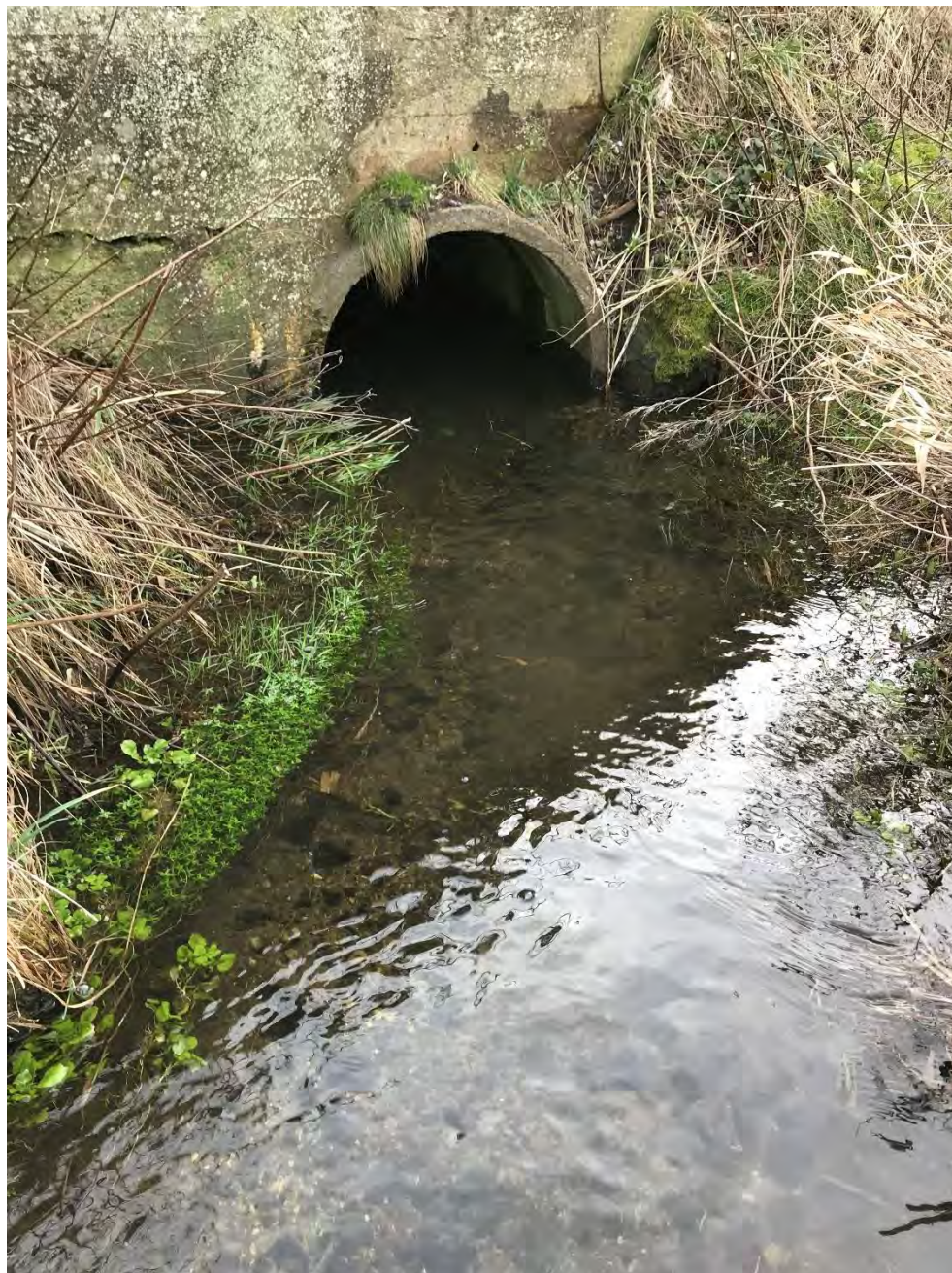
Foto 10. Bækken, rørunderføring under Vadestedvej. Taget i sydlig retning (13.02.2019).
