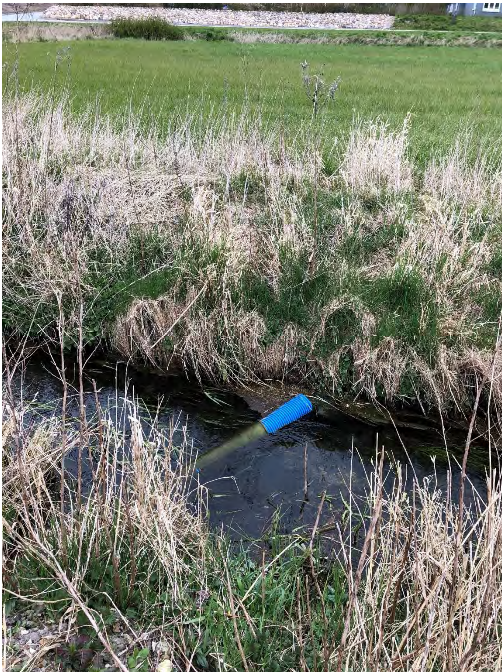
Foto 5: Drænudløb fra den etablerede sø til Bækken. Taget i østlig retning (10.04.2019).
