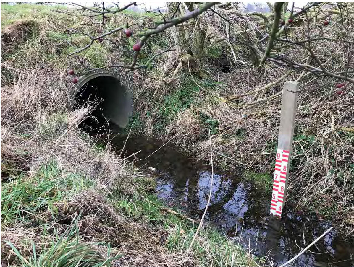
Foto 3: Bækken ved skalapæl 1 og rørunderføring under Åvænget. Taget i nordøstlig retning (22.01.2019).
