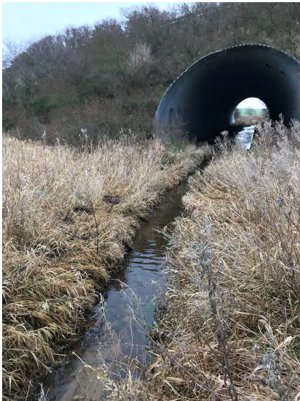
Foto 8: Underføring og faunapassage under Oddesundvej. Taget i sydlig retning (22.01.2019).
